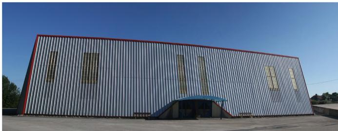
**Le gymnase** fut construit en 1992. A cette époque, le coût des énergies était faible et peu pris en compte dans la construction, de ce fait le gymnase est très mal isolé, il est donc difficile à chauffer en hiver. Le mode de chauffage est le gaz, énergie dont le coût ne cesse d'augmenter. Afin de maîtriser les dépenses, une horloge a été mise en place pour programmer le chauffage uniquement lorsque le gymnase est occupé.
